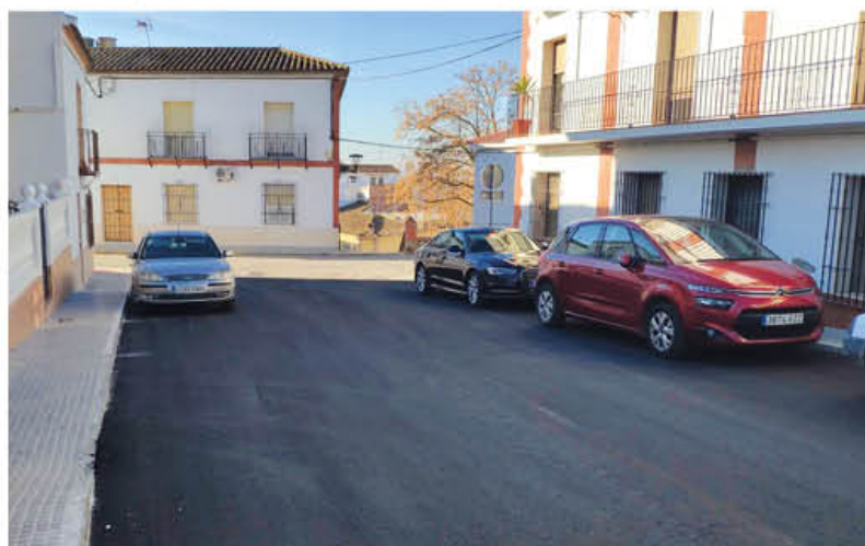
ASFALTADO EN CALLE MOLINO ALTO.
