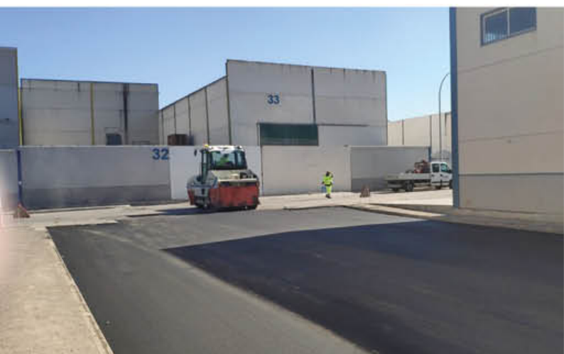
ASFALTADO EN POLÍGONO.
