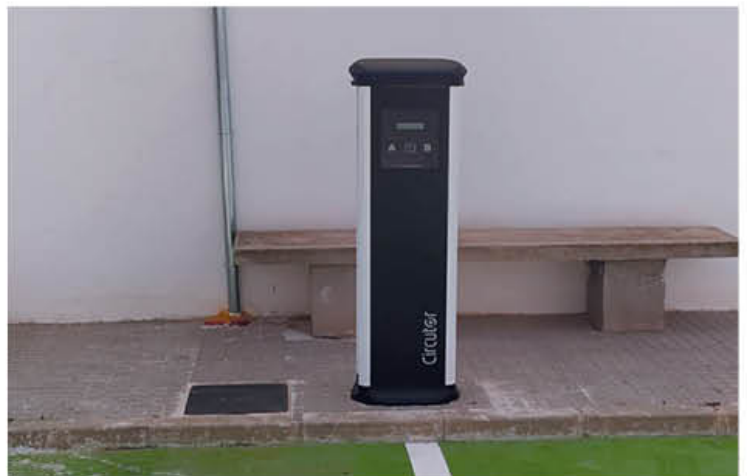
INSTALACIÓN PUNTO DE RECARGA PARA VEHÍCULOS ELÉCTRICOS JUNTO AL PABELLÓN.
