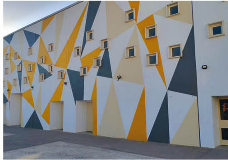
CASA DEL CIUDADANO (PINTADO DE FACHADA).
