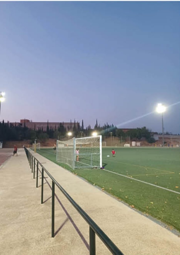
RENOVACIÓN A LED DE INSTALACIONES DE ALUMBRADO PÚBLICO EXTERIOR.
