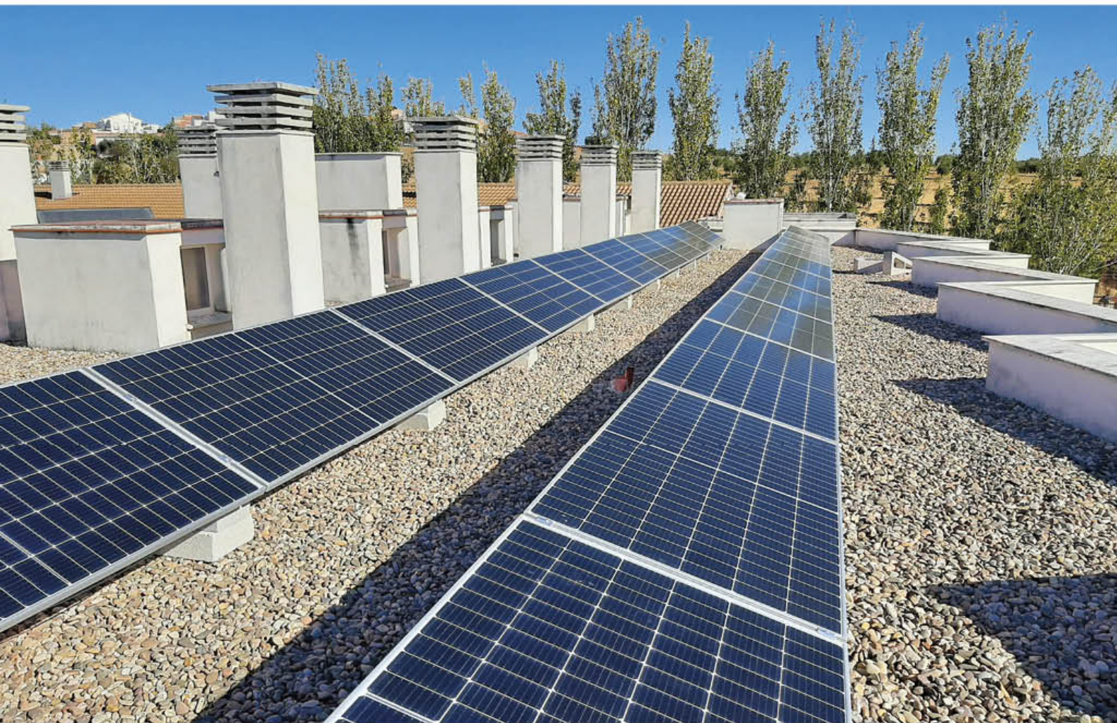
PABELLÓN MUNICIPAL (INSTALACIÓN DE PLACAS SOLARES DE AUTOCONSUMO).
