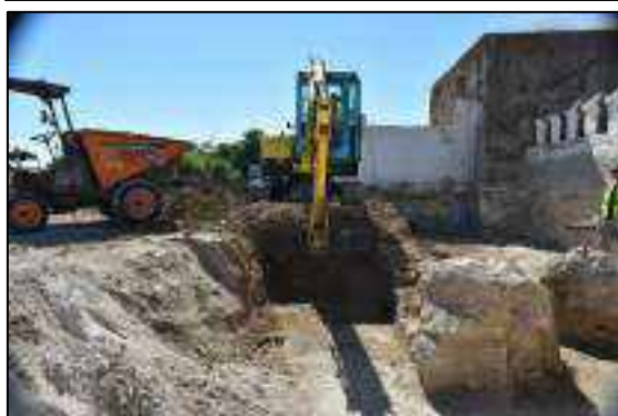
Lám. 28. Retirada de estrato de colmatación de la zona E.
