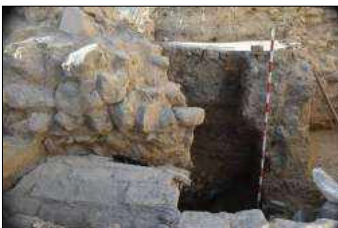
Lám. 164. Avances de los trabajos en el sector de la bóveda, las imágenes muestran la excavación del tacón de rellenos que se localizan bajo el pavimento de yeso.
