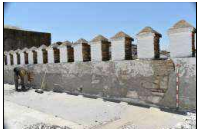
Lám. 3. Muro de cierre sur tras los trabajos de picado.
