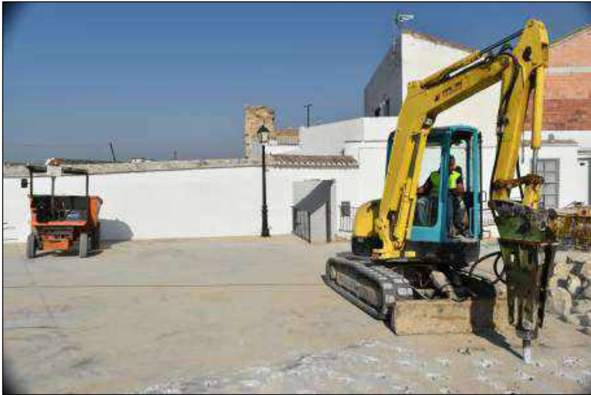
Lám. 92. Picado de la superficie hormigonada de la nueva zona de actuación (espacio ampliado 10 m. en dirección N).
