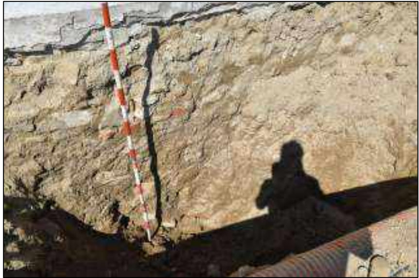
Lám. 112. Sondeo en la base interna o cimentación del muro de la casa de vecina en la zona W que tiene correspondencia al interior del patio de armas del recinto fortificado. La cimentación de este descansa directamente sobre la un estrato amarillento de naturaleza arcillosa y consistencia media.
