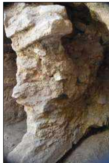
Lám. 171. Cara interna y externa del muro sobre el que apoya la bóveda de ladrillo. Probablemente la bóveda se construya con la intención de contener la estructura superior que monta sobre ella.
