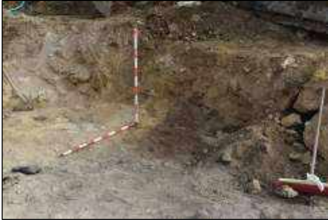
Lám. 103. Estrato negruzco bajo el pavimento de la fortificación que se sitúa en el límite N de la primera zona de actuación, U.E. Nº 41.
