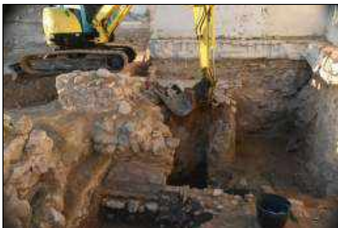
Lám. 193. Retirada mecánica del pavimento de yeso.
