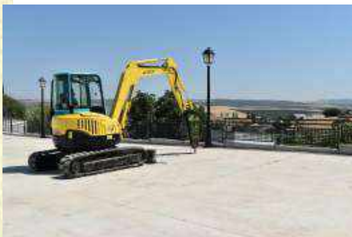
Lám. 5. Inicio de los trabajos de picado de la solera existente en el patio de armas.
