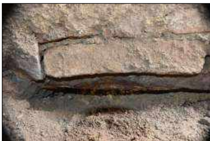
Lám. 172. Imagen de la viga o barra de metal sobre la que construyen el murete de la parte derecha sobre el que apoya la bóveda. Dicho muro queda asentado sobre dicho elemento férreo que asienta a su vez sobre los rellenos contemporáneos que colmatan el espacio de las posibles escaleras de acceso al antiguo recinto.
