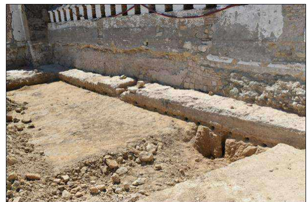
Lám. 74. Vista general del lienzo S de muralla una vez visible la línea de mechinales que inician el alzado de la misma.
