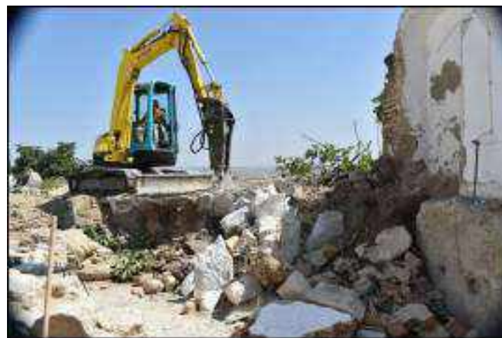
Lám. 41. Trabajos desempeñados en el límite E del recinto del patio del castillo. Amortización del cajón de ladrillo adosado a un muro anterior de la vivienda (también de ladrillo) y picado del zuncho sobre el que asentaba el murete que sostenía la barandilla metálica.
