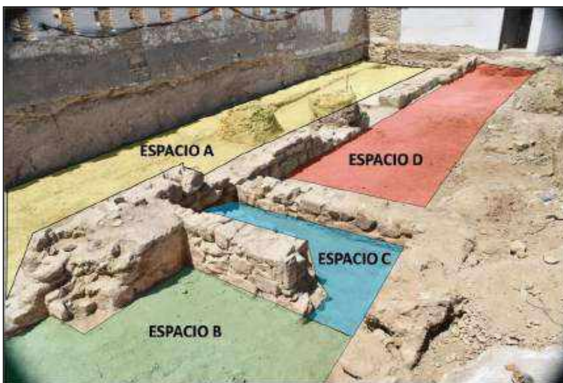
Estructuras correspondientes a los Espacios A, B, C y D de la denominada "Casa del Castillo"
