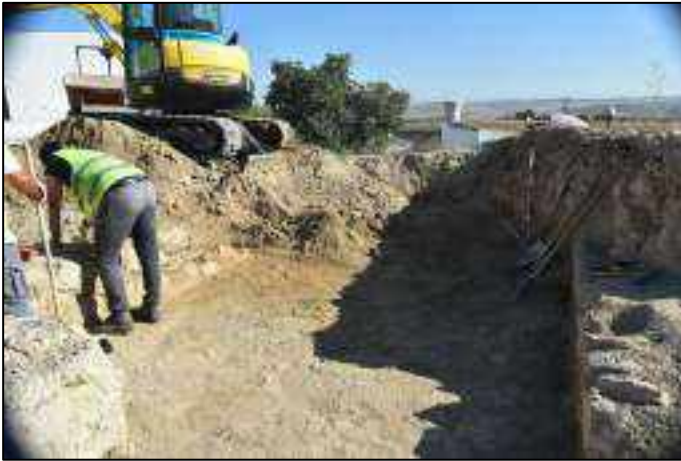
Lám. 52. Excavación y limpieza del sector N-E del yacimiento.
