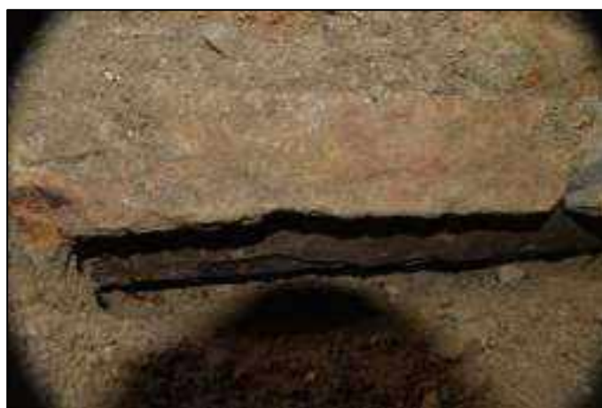
Lám. 172. Imagen de la viga o barra de metal sobre la que construyen el murete de la parte derecha sobre el que apoya la bóveda. Dicho muro queda asentado sobre dicho elemento férreo que asienta a su vez sobre los rellenos contemporáneos que colmatan el espacio de las posibles escaleras de acceso al antiguo recinto.
