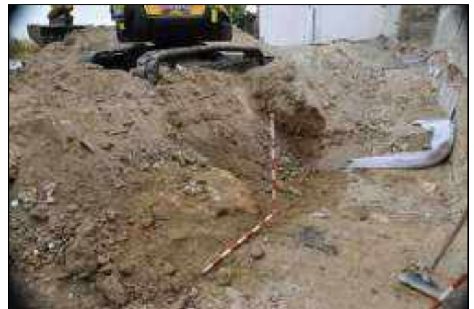
Lám. 15. Rellenos y estructura emergente de la posible cimentación de la caseta del antiguo cine.
