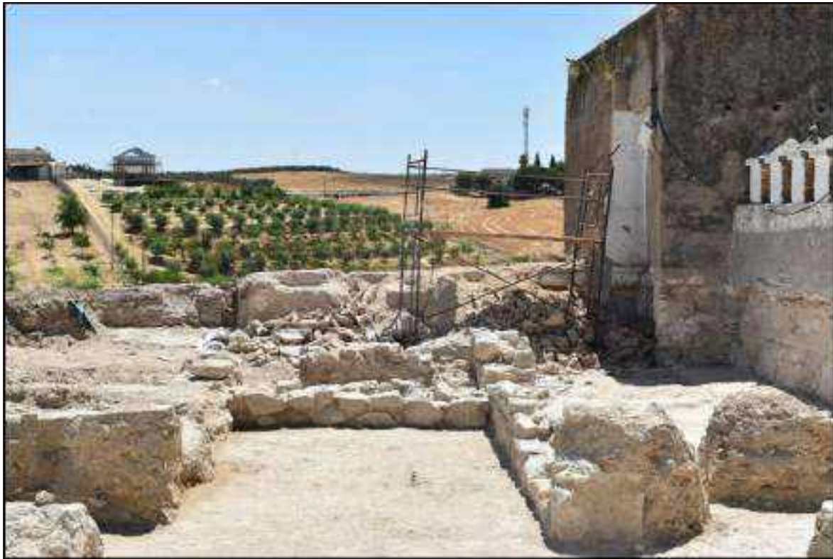
Lám. 48. Imagen del yacimiento una vez derribados los muros de ladrillo que se construían sobre el parapeto de la muralla E de tapial.
