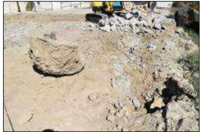
Lám. 100. Tacón de hormigón bastardo extraído de la zona ampliada, parece ser la cimentación de unas antiguas farolas del cine de verano.
