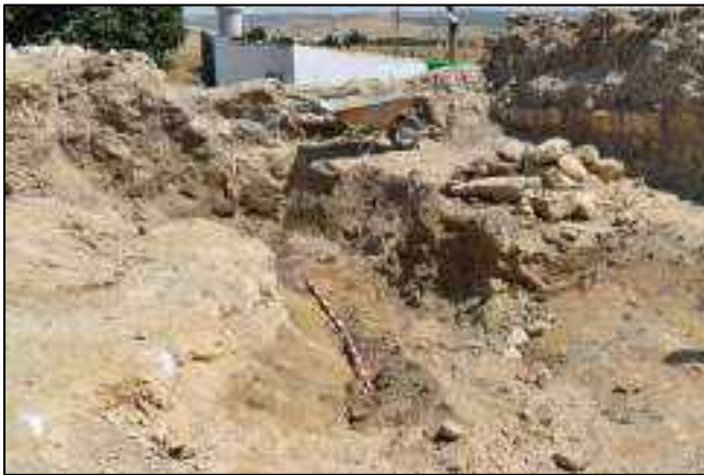
Lám. 77. Sobre un relleno de tierra amarronada se localiza la cama o preparado de mampuestos sobre el que se construye el primer pavimento de algunas de las estancias de la Casa del Castillo.
