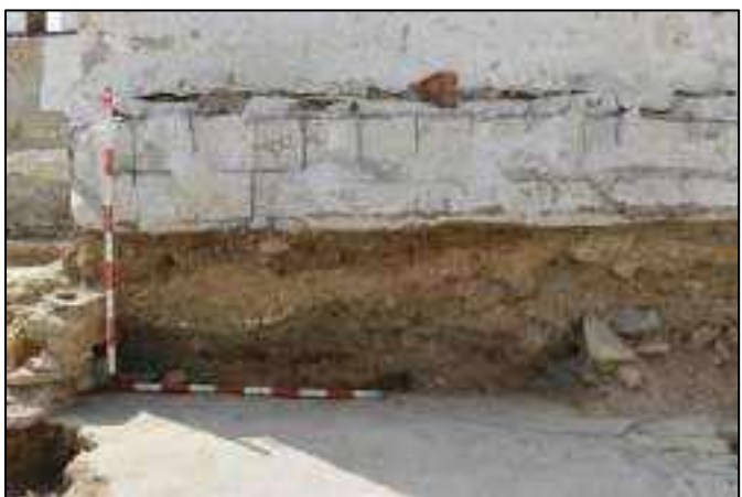
Lám. 131. Estratigrafía de la zona S de la antigua caseta de materiales, documenta al menos tres niveles de relleno entre (bajo) la caseta y (sobre) el pavimento de yeso.
