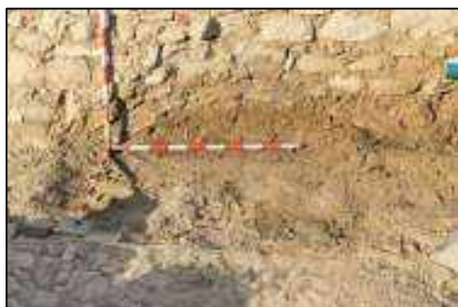
Lám. 173. Arco de ladrillo con mortero de cemento que forma parte del muro de cimentación de la casa vecina conocida como "Casa de Torito".
