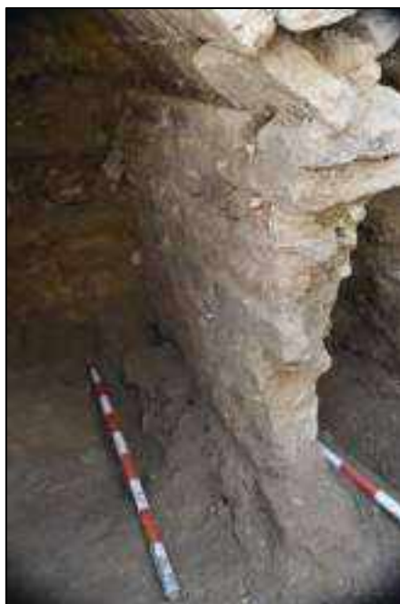
Lám. 171. Cara interna y externa del muro sobre el que apoya la bóveda de ladrillo. Probablemente la bóveda se construya con la intención de contener la estructura superior que monta sobre ella.
