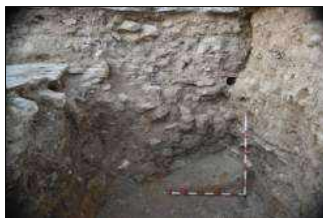
Lám. 144. Muro de cierre del Monumento de los Caídos visto desde el interior en el que se aprecia un estrato de relleno amarillento, parece ser que se trata de arcilla.
