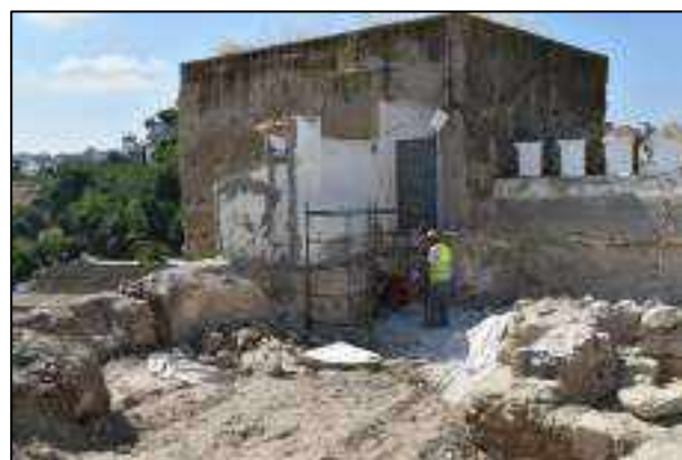
Lám. 47. Reportaje fotográfico de los trabajos mecánicos y manuales del derribo de los muros de ladrillo que se localizan sobre el parapeto de la muralla de tapial E.
