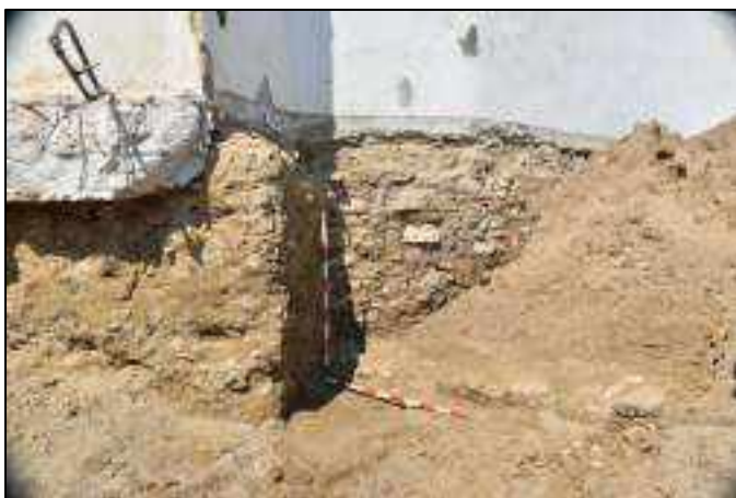
Lám. 127. Muro que discurre en oblicuo, entre la cimentación de la casa aldeaña y el muro de tapial de la lámina 126.
