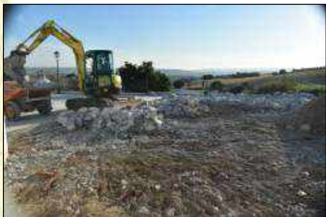
Lám. 7. Retirada del escombro generado tras el picado de la solera de hormigón.
