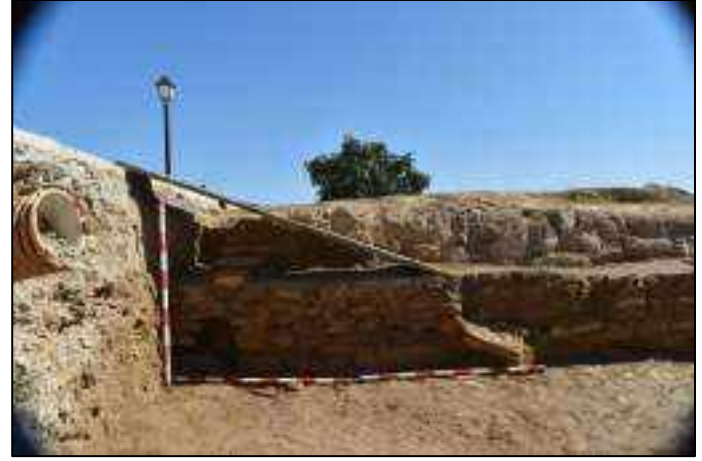
Lám. 182. Muro de cierre E de la estancia pavimentada, este presenta diferentes fábricas, predominando la construida con pequeños mampuestos y la de ladrillo.
