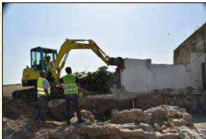
Lám. 41. Trabajos desempeñados en el límite E del recinto del patio del castillo. Amortización del cajón de ladrillo adosado a un muro anterior de la vivienda (también de ladrillo) y picado del zuncho sobre el que asentaba el murete que sostenía la barandilla metálica.
