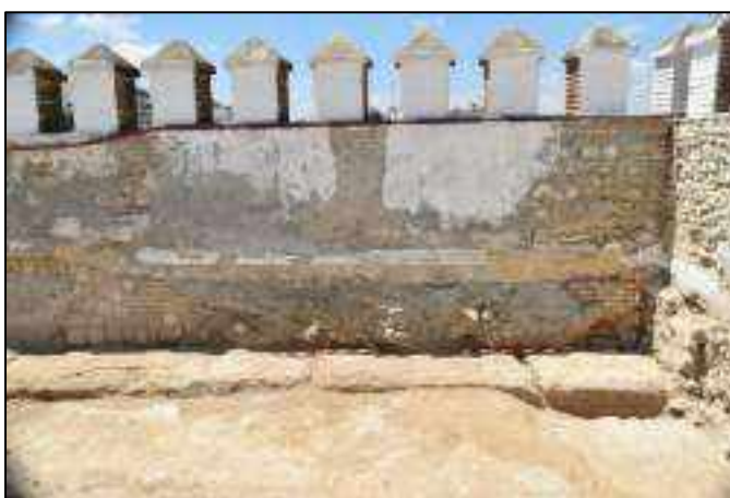
Lám. 16. Imagen de la fase de derrumbe del muro S restaurada con hormigón en la década de los años '70 del siglo pasado.
