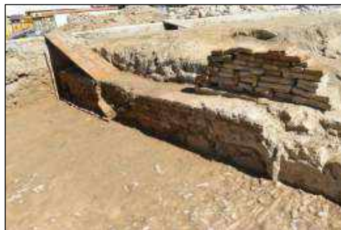
Lám. 183. Imagen general del muro de cierre E de la estancia del pavimento de cantos rodados y ladrillos.
