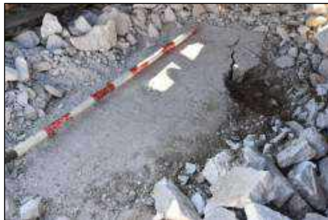
Lám. 8. Restos de hormigón bastardo que formaba parte de la anterior solera del recinto.
