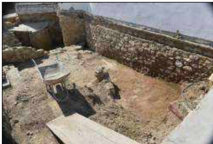
Lám. 176. Avances en la excavación de la zona del pavimento de cantos rodados, al W del mismo emerge otro pavimento de ladrillo.
