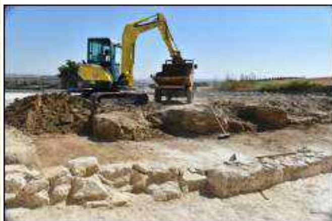
Lám. 39. Maquinaria trabajando en la excavación de los tres posibles pilares localizados en el espacio D.
