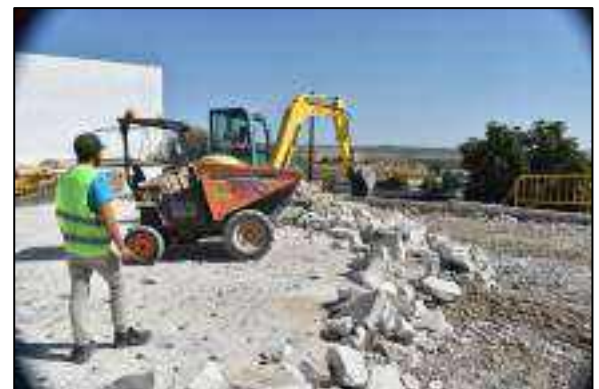
Lám. 97. Trabajos de retirada de hormigón de la nueva zona de intervención (ampliación).
