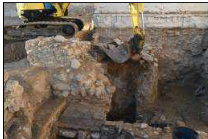
Lám. 193. Retirada mecánica del pavimento de yeso.
