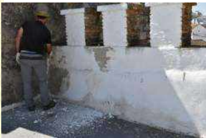
Lám. 2. Inicio de los trabajos de picado en la parte superior del muro de cierre sur.
