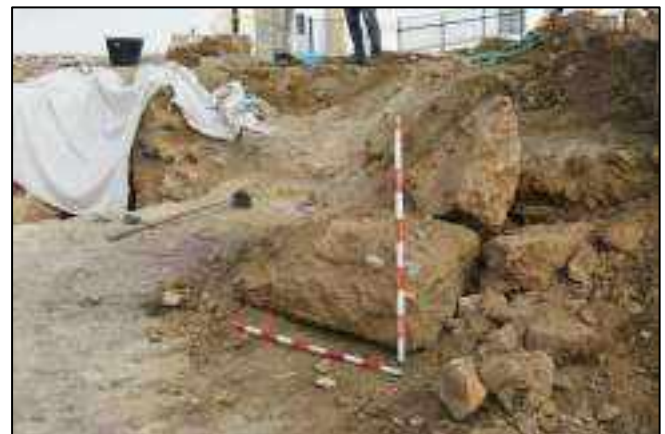
Lám. 102. Retirada de los últimos restos del posible pavimento original del recinto fortificado, que intestan con lo que entendemos como cerro original donde se encuentran los estratos del Bronce Final.
