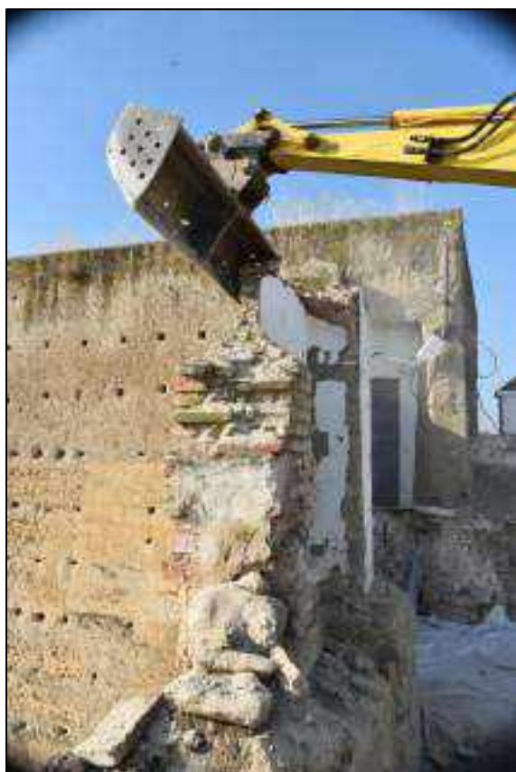
Lám. 47. Reportaje fotográfico de los trabajos mecánicos y manuales del derribo de los muros de ladrillo que se localizan sobre el parapeto de la muralla de tapial E.
