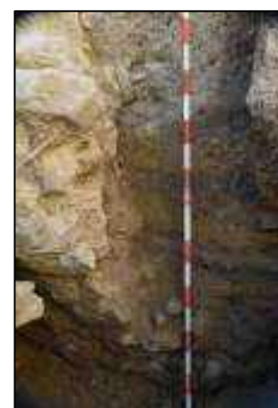
Lám. 164. Avances de los trabajos en el sector de la bóveda, las imágenes muestran la excavación del tacón de rellenos que se localizan bajo el pavimento de yeso.
