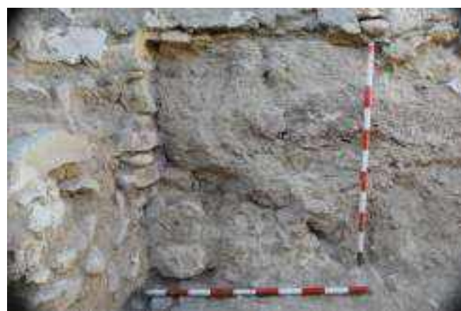
Lám. 21. Lienzo de tapial de la muralla S del recinto fortificado en su encuentro con la torre SE.
