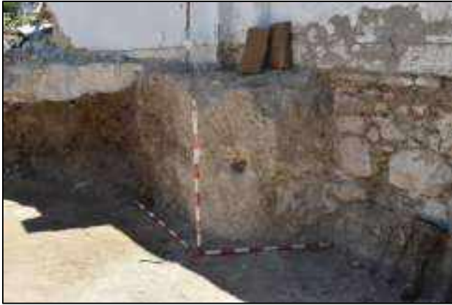
Lám. 32. Aparición del parapeto de la muralla de tapial en la zona E del recinto, U.E. 1000 B. Muestra buen estado de conservación.
