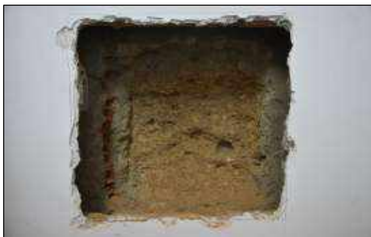
Lám. 89. Sondeo paramental 1, realizado en una de las estancias interiores de la segunda planta del juzgado con el objetivo de comprobar si la muralla se prolongaba hacia abajo o por el contrario formaba parte todo del relleno compacto.
