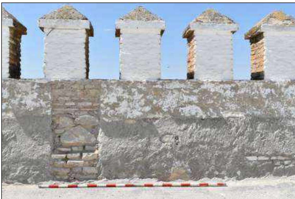
Lám. 4. Cata paramental realizada en el muro almenado de la zona sur de intervención para identificar las diferentes fábricas del mismo.
