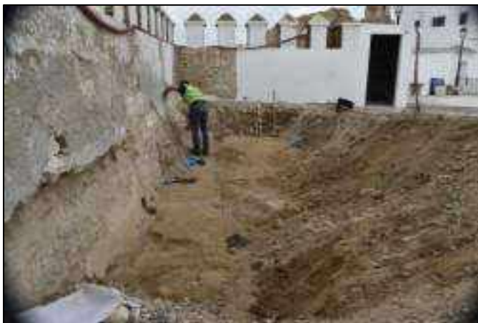
Lám. 14. Limpieza del muro S tras la retirada del estrato de relleno de la intervención de 2017.
