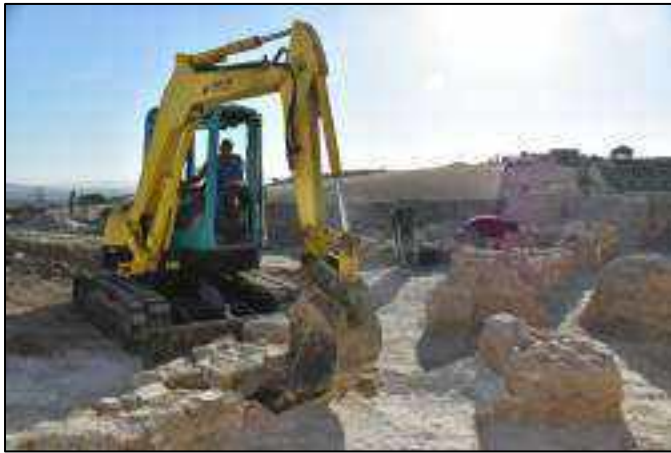
Lám. 66. Amortización de algunas de las estructuras murarias que conforman la casa del castillo.
