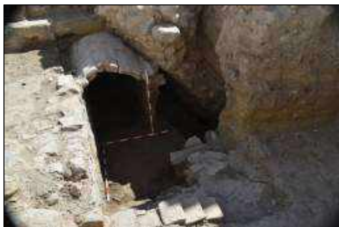
Lám. 158. Sector bóveda de ladrillo visto desde arriba, desde donde se aprecian nuevos elementos emergentes.
