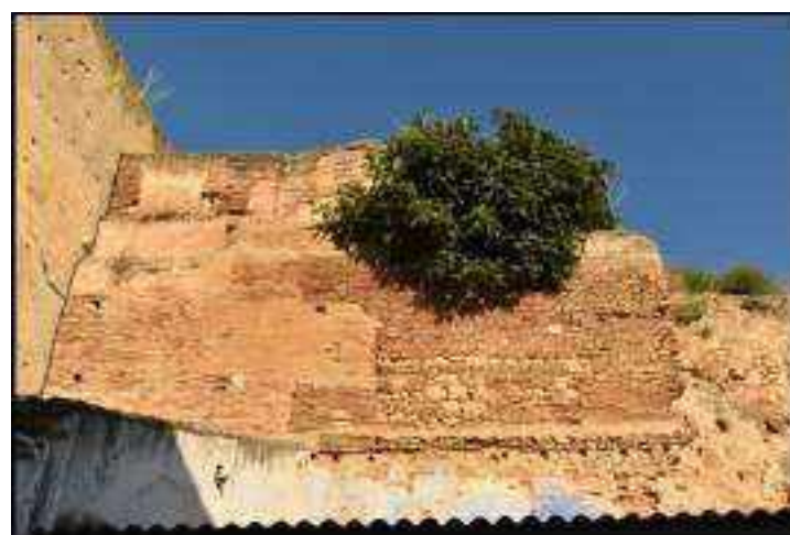
Lám. 43. Vista exterior del muro de cierre E del recinto del castillo. Estructuras en ladrillo que se construyen sobre la muralla y se adosan al torreón.
