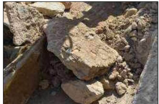
Lám. 85. Detalle de la composición del pavimento sobre el que se asentaba la Casa del Castillo. En algunas zonas posee un espesor máximo de unos 30 cm.
