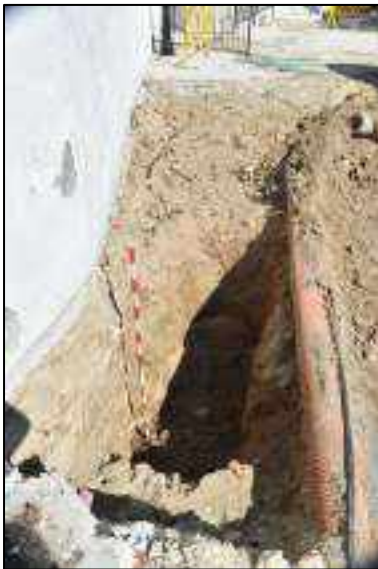
Lám. 112. Sondeo en la base interna o cimentación del muro de la casa de vecina en la zona W que tiene correspondencia al interior del patio de armas del recinto fortificado. La cimentación de este descansa directamente sobre la un estrato amarillento de naturaleza arcillosa y consistencia media.
