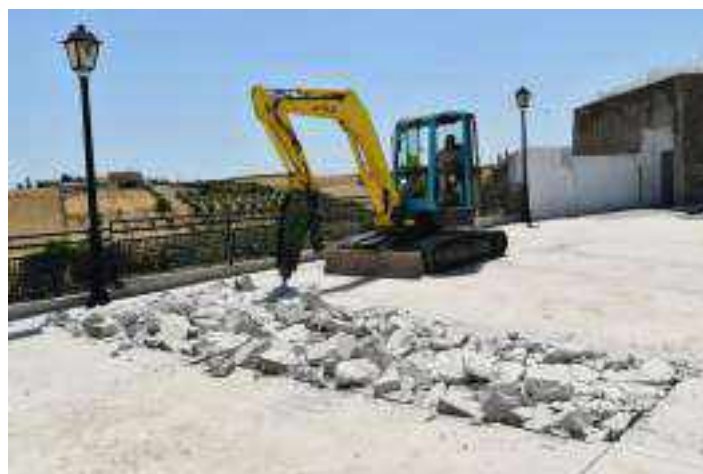
Lám. 6. Imagen de los trabajos de picado de la solera de hormigón.
