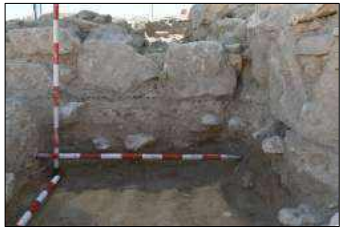
Lám. 69. Imagen del sondeo practicado en el Espacio D de la Casa del Castillo donde se aprecia la ausencia de cimentación en las estructuras murarias que conforman dicho inmueble.
