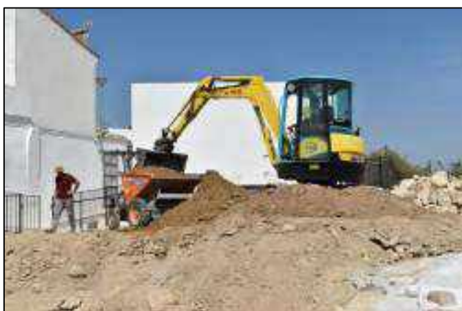
Lám. 154. Retirada de tierra durante la última jornada de trabajos mecánicos.
