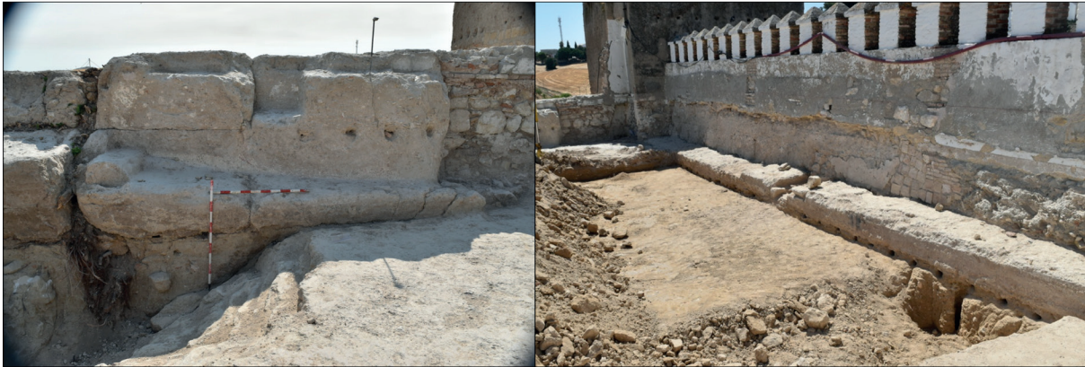
Figura 12. Lienzos de la muralla este (izquierda) y sur del castillo, construidos sobre la superficie de ampliación del cerro. El grosor de ambos lienzos se encuentra devastado debido a las reformas ocasionadas por la construcción de la vivienda intramuros del siglo XVI
