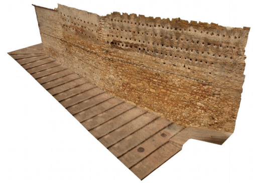
Figura 9. Vista general del lienzo de muralla conservado en calle Concepción. Captura del levantamiento fotogramétrico realizado previamente a su restauración (Bayo et al. 2017)
