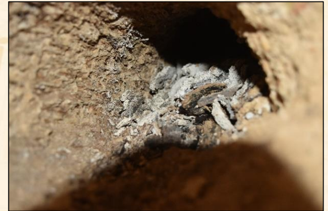
Vigas de madera que arman una de las hiladas de la torre del recinto de Hornos de Segura (Márquez Bueno, 2018)
