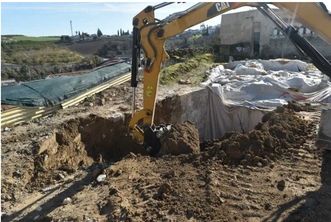
Láminas 151. Extracción del relleno del aljibe.
