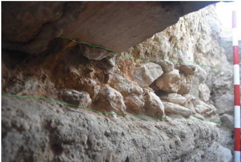
Lámina 18. Murete sobre el que se asienta la bóveda de ladrillo.
