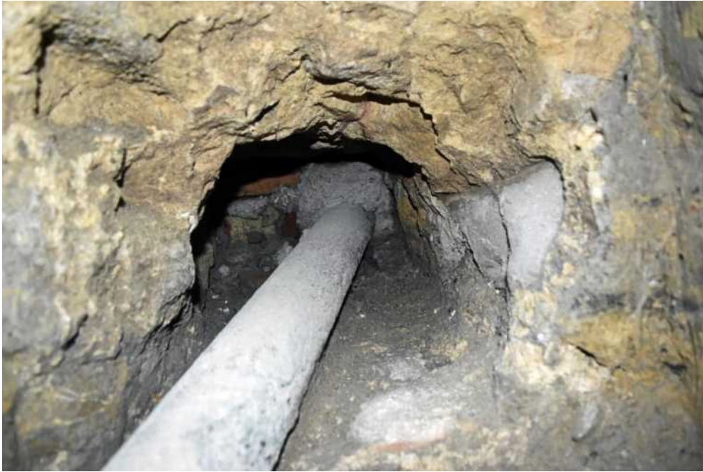
Láminas 19. Detalle de la tubería de plomo que abastecía de agua al aljibe.
