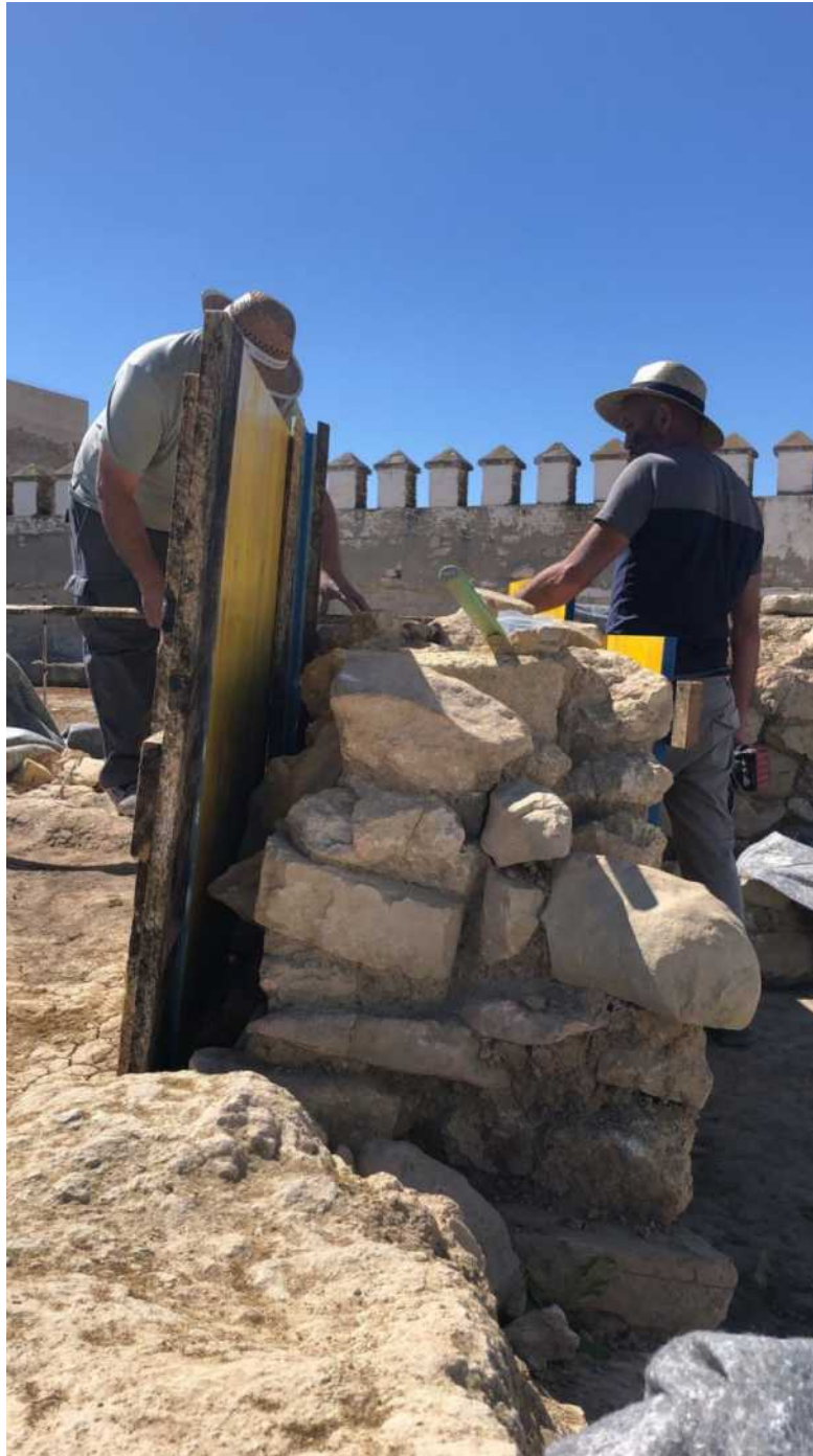
Inicio de protección y entibación de muros.
