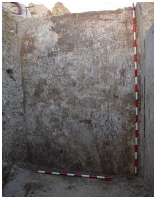
Lámina 10. La cara interna del aljibe se encuentra revestido por una capa de cemento y por varias capas de pintura hidráulica de colora blanca y roja.
