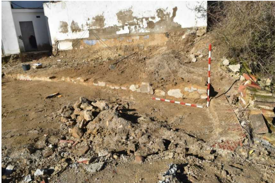
Láminas 142y 143. Muro que delimita el antiguo escenario.
