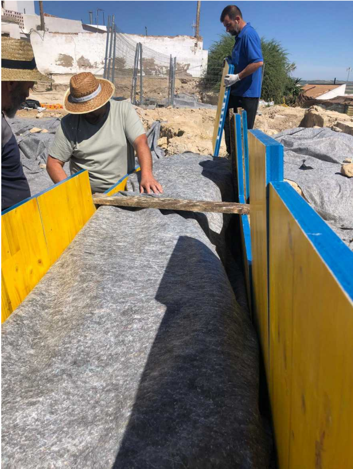
Cubrición con geotextil y paneles de madera arriostrados.
