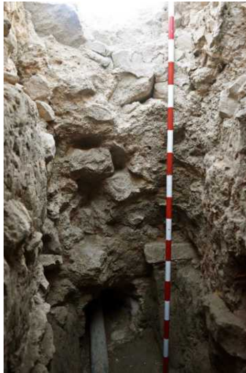
Lámina 9. Fotografía realizada desde el interior de la zanja por donde discurría la tubería. Creemos que la cara externa del aljibe que estaba construido con nódulos calizos dispuestos en filas más o menos horizontales asegurados con cemento.
