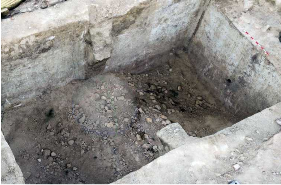
Lámina 13. Arco de descarga parcialmente derruido y que posiblemente soportara algún tipo de cubierta.
