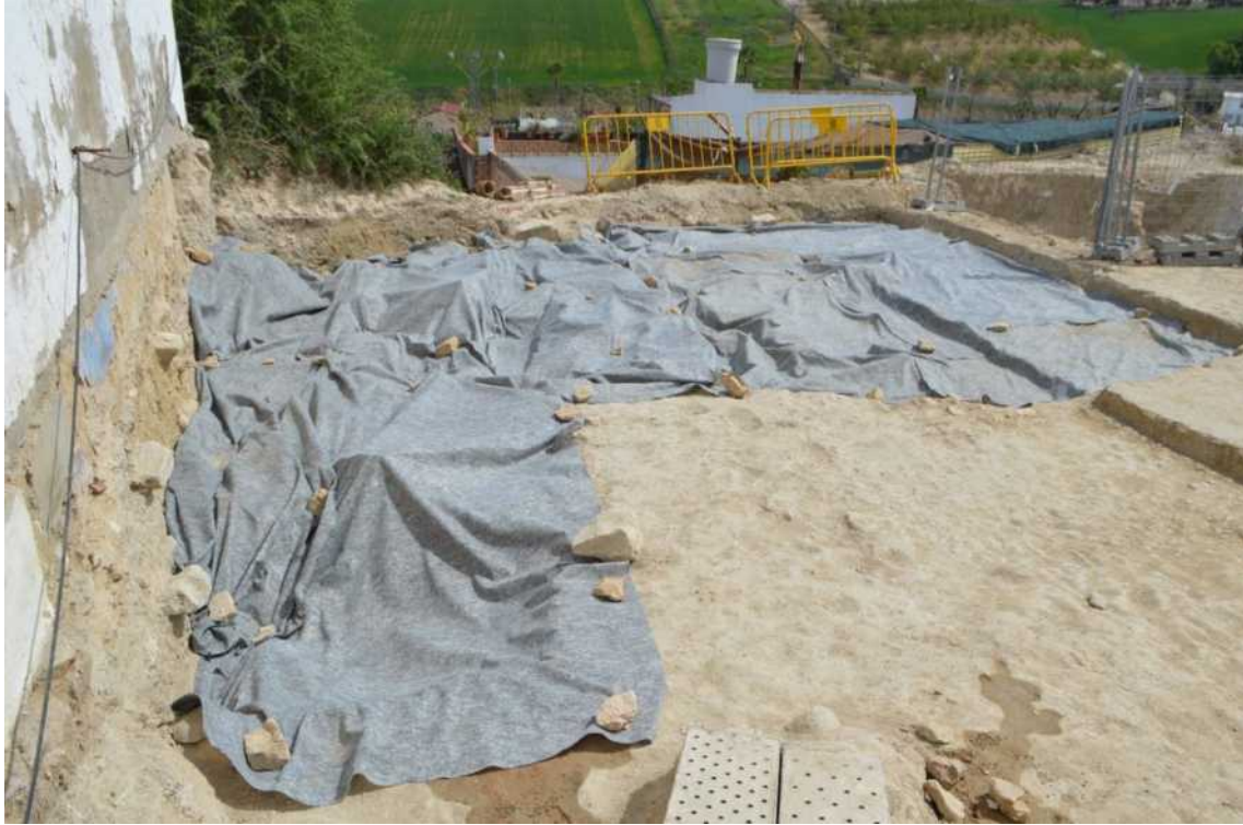
Protección con geotextil de la zona norte de la excavación.
