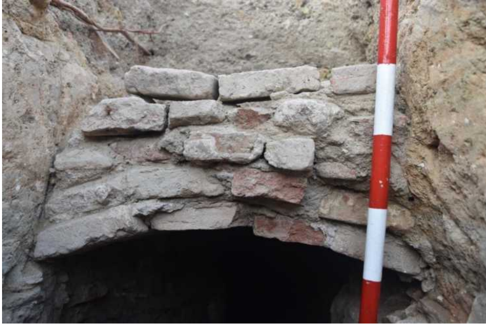
Lámina 17. Bóveda de ladrillo que discurre a lo largo de la zanja. Su funcionalidad era proteger a la tubería de plomo que abastece de agua al aljibe.
