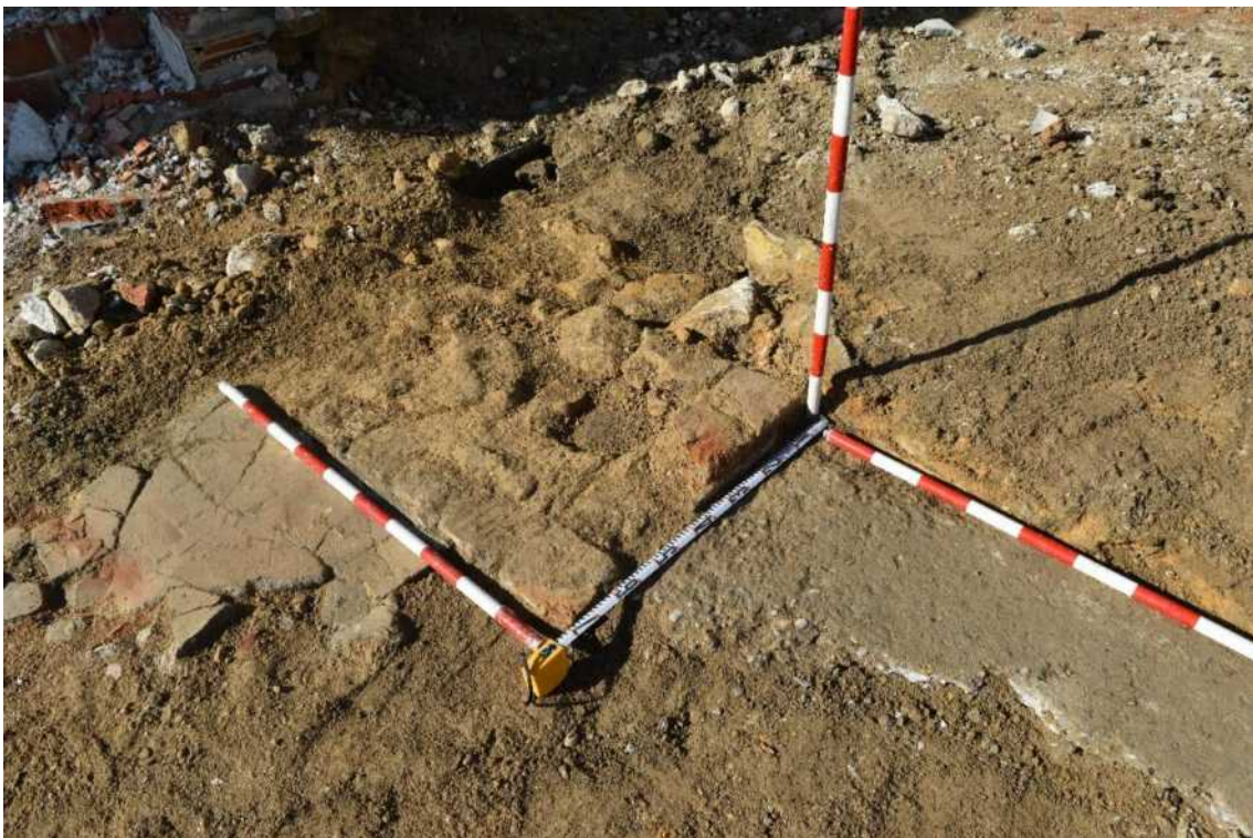
Láminas 148. Suelo compuesto por cemento bastardo y que era el pavimento del antiguo cine de verano.
