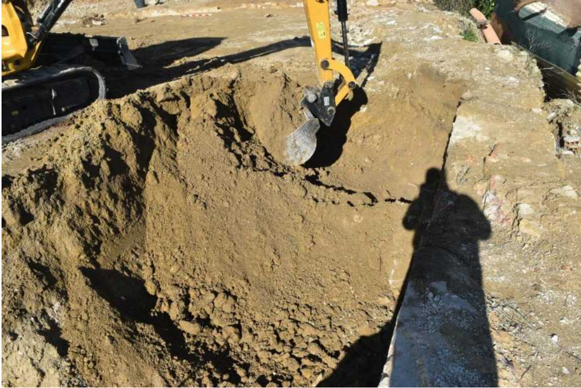
Láminas 150. Delimitación y excavación del interior del aljibe.
