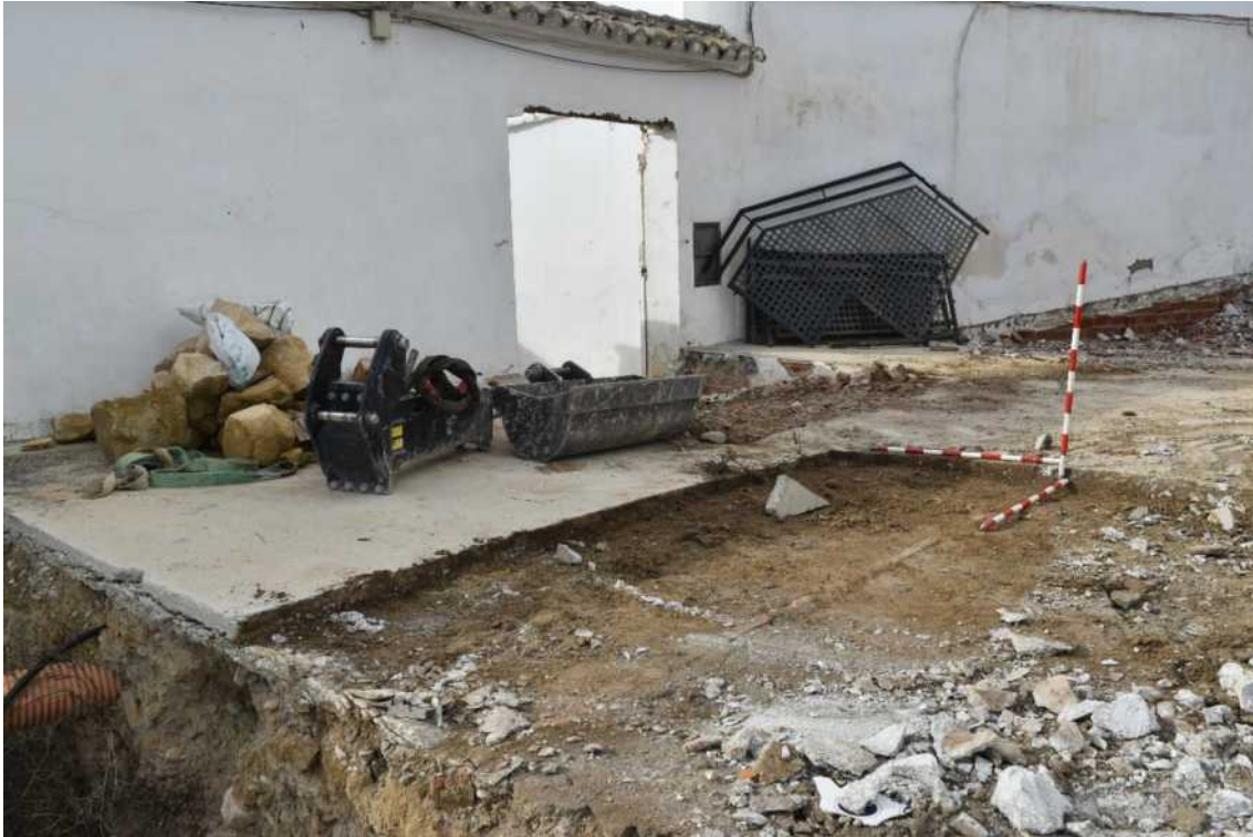
Láminas 148. Suelo compuesto por cemento bastardo y que era el pavimento del antiguo cine de verano.
