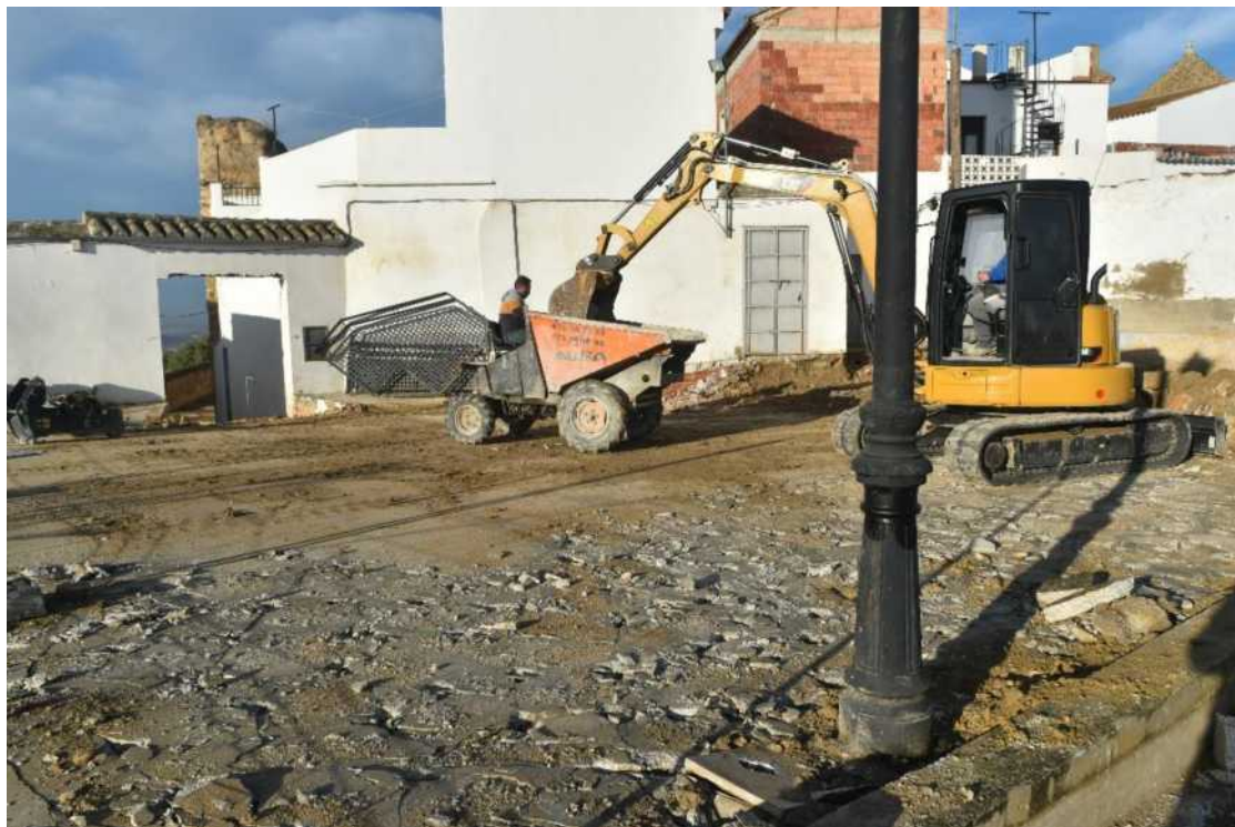
Láminas 146. Desmante del muro de cierre del recinto.
