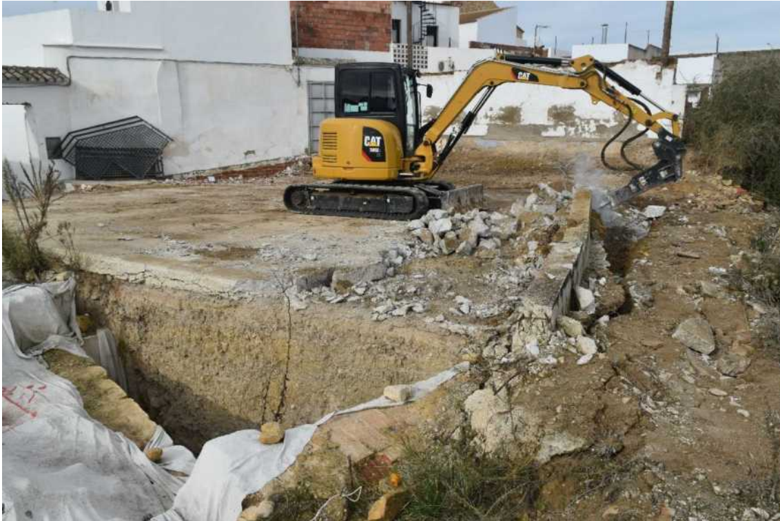
Láminas 146. Desmante del muro de cierre del recinto.
