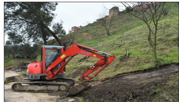
Lám. 9: Trabajos mecánicos realizados en el Sector I.
