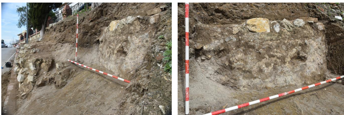
Lám. 25: Parte de la cara externa del muro del aljibe que se localiza en el talud perteneciente al Sector II, Rodal 2 de la intervención (U.E 13).
