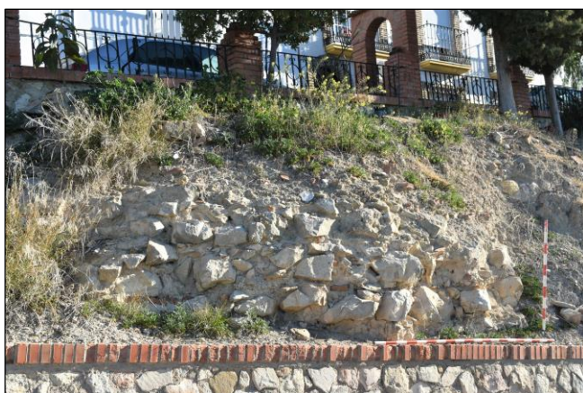
Lám. 17: Muro de contención (U.E 12). Estado previo a su excavación y limpieza superficial.
