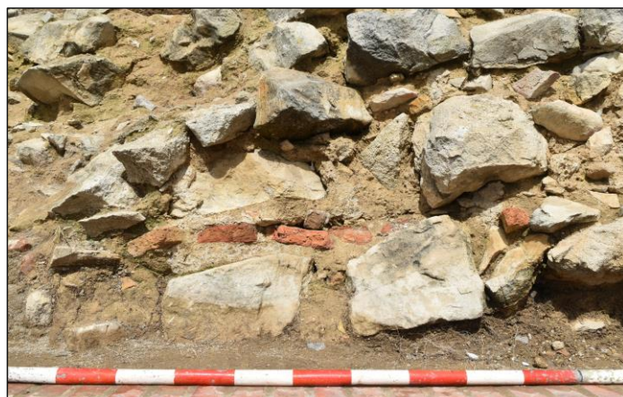
Lám. 22: Detalle de los elementos constructivos que conforman la edificación de la U.E 12.
