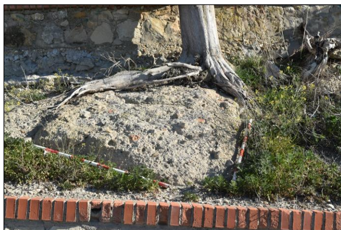
Lám. 16: Muro de Opus Caementicium (U.E II) antes de iniciar su excavación y limpieza superficial.
