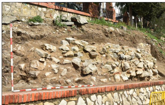
Lám. 21: Muro de contención (U.E 12) una vez culminado su proceso de limpieza y excavación.
