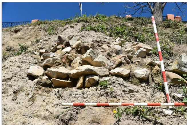
Lám. 45: Imagen de la estructura U.E 23 previa a su limpieza.
