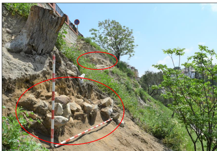
Lám. 44: Vista general de la U.E 3. En rojo quedan marcadas las principales acumulaciones de piedra localizadas y que forman parte de este estrato de derrumbe.
