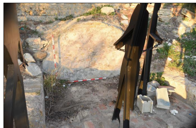
Lám. 18: Estado en el que se encontraba la estructura hidráulica localizada en el Sector II, Rodal 2 (UU.EE 15, 16, 17 y 18)
